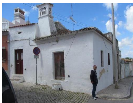
Figura 5 - Edifício do tipo Casa antiga do ipo rural
